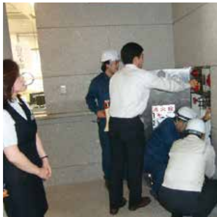
屋内消火栓の操作
