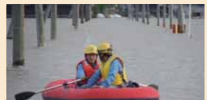
浸水した地域での停電復旧作業
