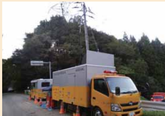
電源車による停電復旧作業
