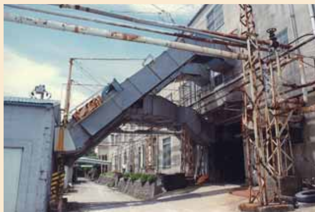
昭和52年5月19日 旧本社工場（若林区古城）塗装場（写真左端に写る建物）から出火
