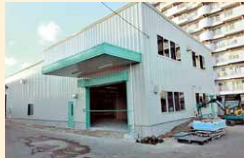
2022年12月完成の新倉庫
