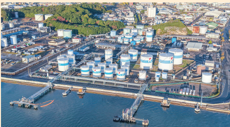
カメイ株式会社 塩釜貞山油槽所
