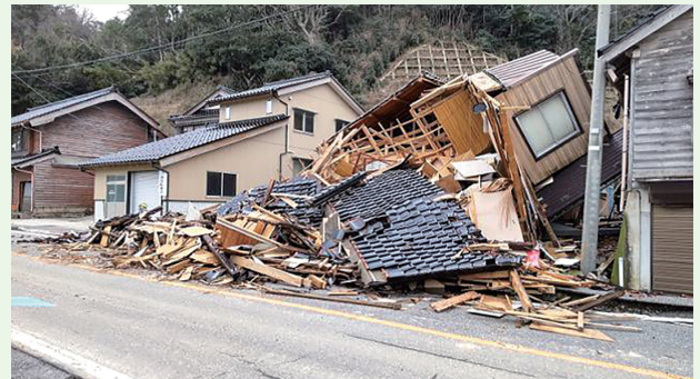
図4 令和6年能登半島地震による家屋の倒壊 (気象庁災害時地震・津波報告「令和6年能登半島地震」より)
