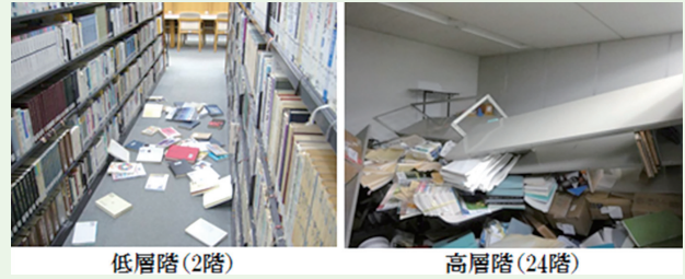
図8 東日本大震災時の東京都内の同一ビルにおける低層階と高層階の被害状況（気象庁ホームページより）
