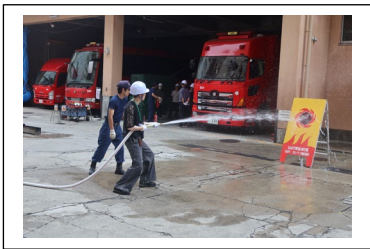
屋内消火栓取扱（青葉地区）
