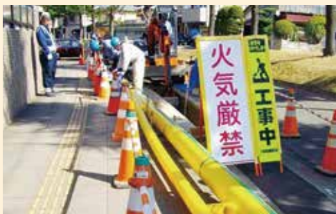
ガス管入替工事
